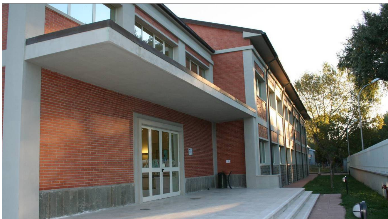
la struttura dove hanno sede la Presidenza, le direzioni generale, sanitaria e scientifica
